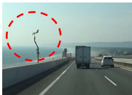
写真-1 浜名大橋に設置している風速計
