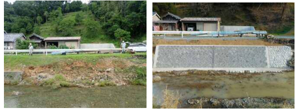
写真-4 被災時（左）完成時（右）の状況
