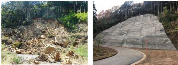
写真-1 被災時（左）完成時（右）の状況
