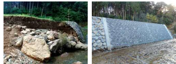
写真-5 被災時（左）完成時（右）の状況
