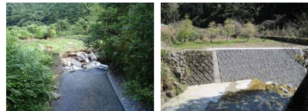
写真-6 被災時（左）完成時（右）の状況
