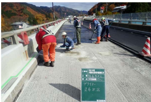
写真-7 高浸透型床版複合防水
