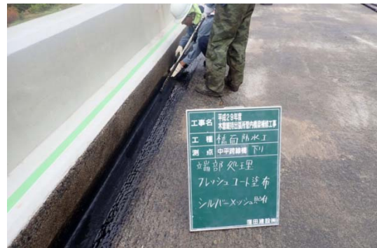
写真-8 床版防水層の端部処理
