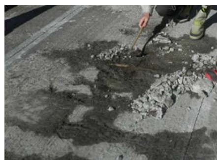
写真-4 職員による床版調査
