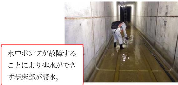
写真-2 共同溝付帯設備の不具合状況
