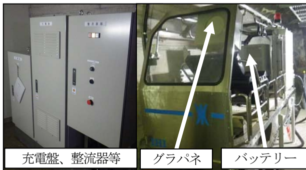
写真-4 改造後モノレール外観(左：盤類、右：搬器)
