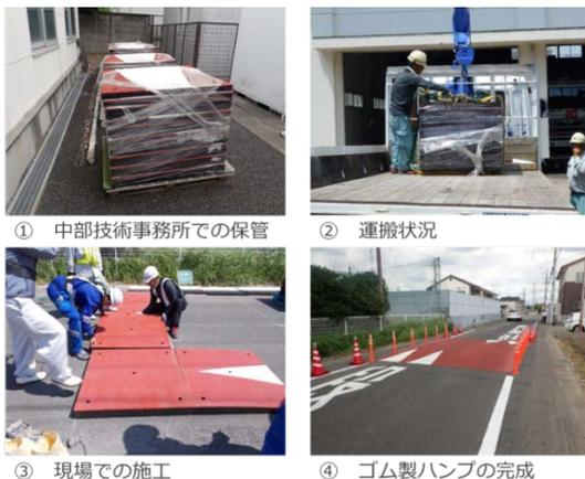
図-3, 5 ハンプ設置までのプロセス
