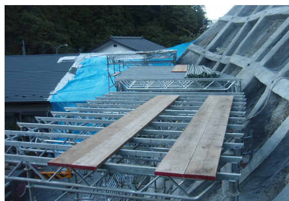
写真-3 足場板設置
