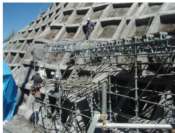
写真-2 支柱材組立
