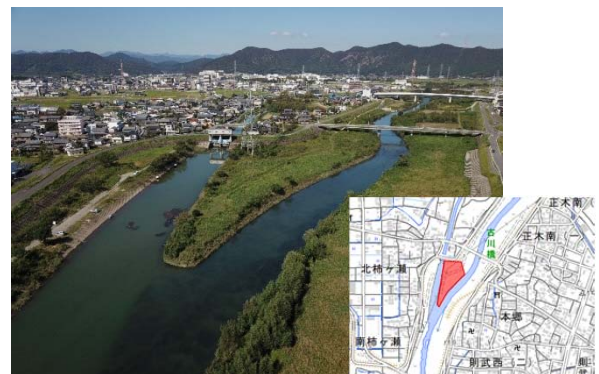
図-3 伊自良川木田地区河道掘削工事箇所
