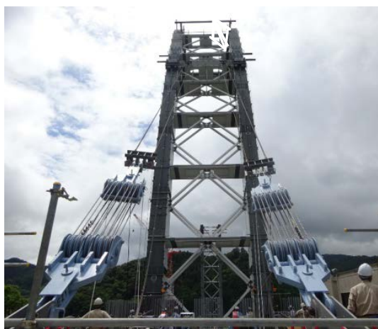
写真-3 2次ロアリング状況
