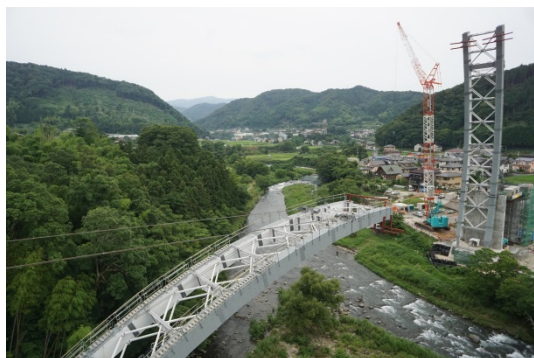
写真-4 3次ロアリング状況
