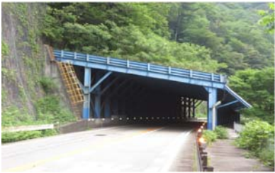
図 2-3 管内最古の鋼製ロックシェッド（門原門型シェッド、1972. 12 完成）
