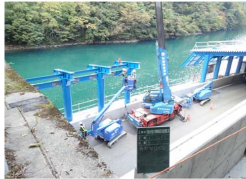
図 3-2 シェッド延伸工事風景 (H30. 10 月時点)
