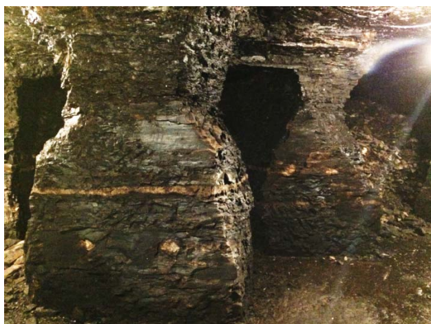
写真-1 現在の坑内残柱状況。
