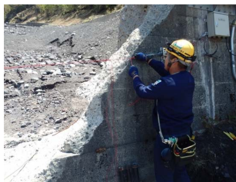
図-11 ワイヤーセンサー交換作業（大滝）
