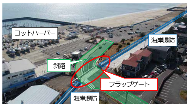
写真-2 阿漕浦・御殿場1工区周辺状況
