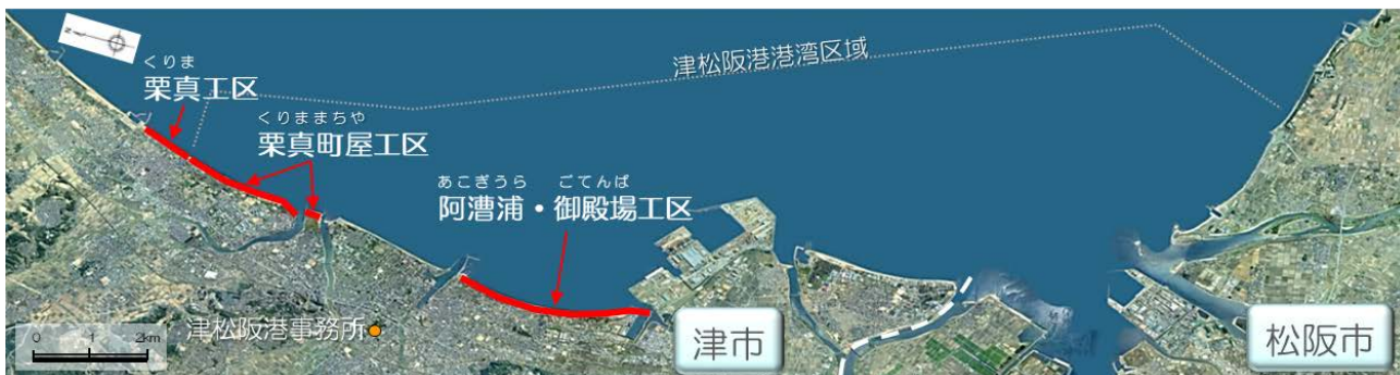
写真-1 津松阪港海岸保全施設改良整備区域
