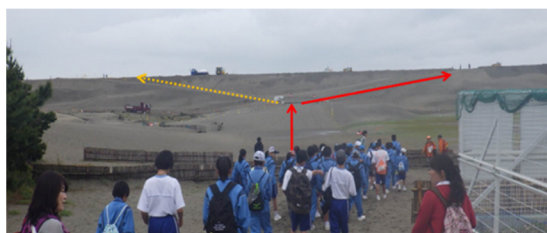
写真-7 工事中の誘導路
