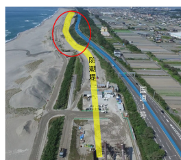
写真-2 防潮堤ルート の並走
