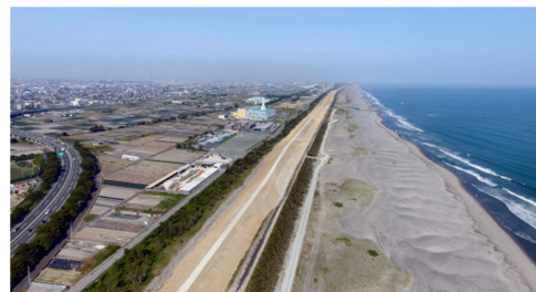
写真-1 一般エリアの防潮堤
