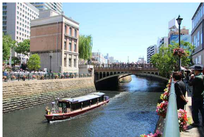
写真-1 景観に配慮した堀川の護岸
