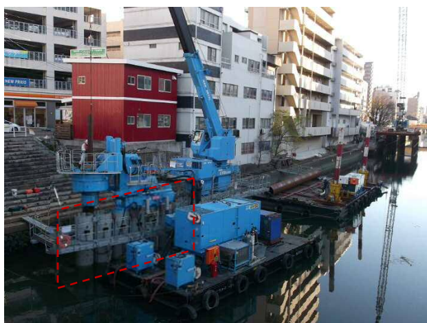
写真-2 自走用仮設杭を使用した工事の様子
