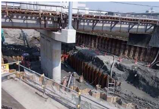
写真-4 山崎川 JR 鉄道橋梁補強工事の様子
