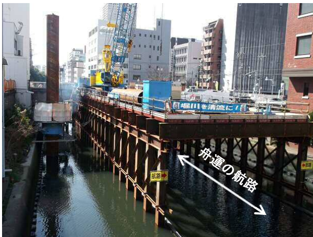
写真-3 堀川五条橋地区の護岸改修工事の様子
