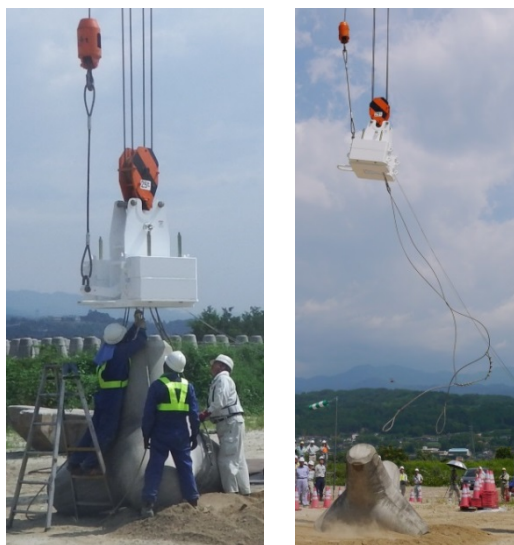
写-3 左：玉掛け 右：空中切離
