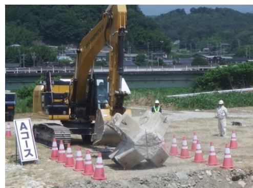
写-1 ケース1（ブロック投入）
