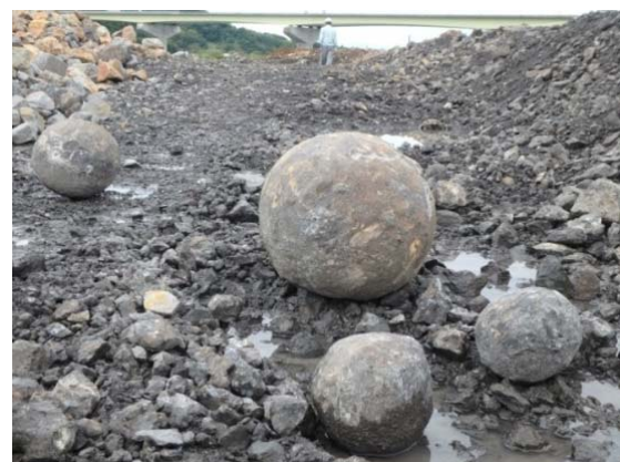
図-5 掘削時に発見した「だるま石」
