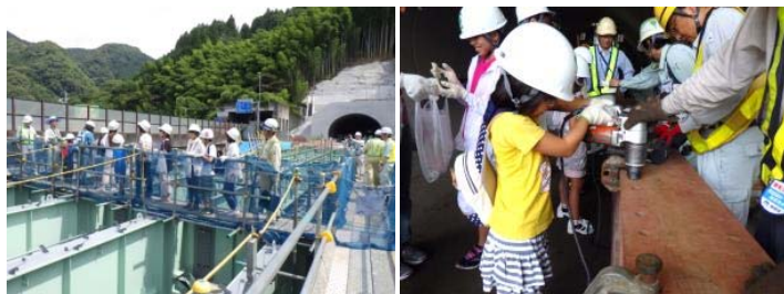
工事中の橋を空中散歩
