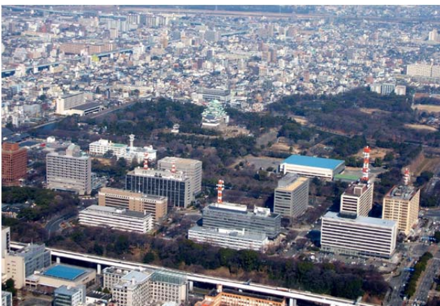
写真-1 三の丸地区の街区風景
