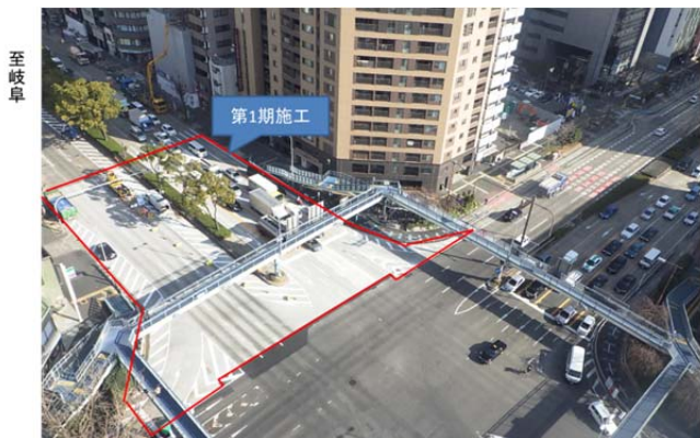
写真-3 現況写真
