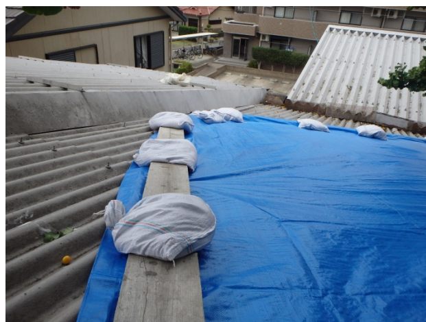
写真-4 屋根をブルーシートで仮補修した様子
