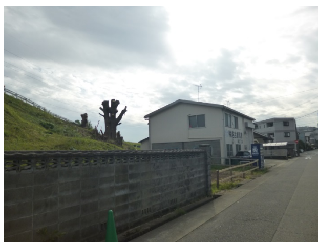
写真-7 再発防止策実施後
