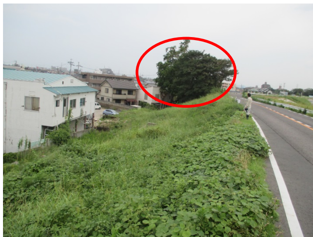
写真-3 堤防裏法面から撮影した事故現場の様子 (事故現場が完全に覆われている。)
