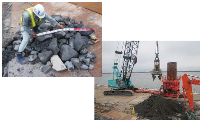
図-8 支障物(φ400mm程度)・先行削孔状況
