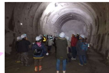
トンネル終点
