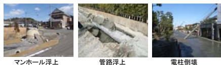
図3 東日本大震災における液状化の伝送路被害例(1) (2) (3)
