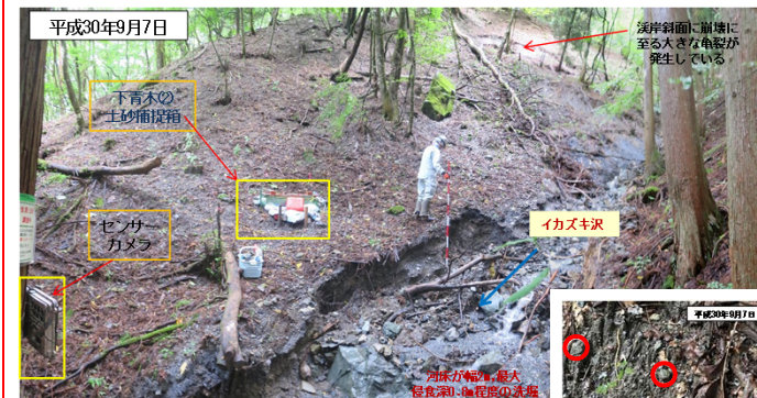
写真-3 土石流発生後の下青木地区の状況
