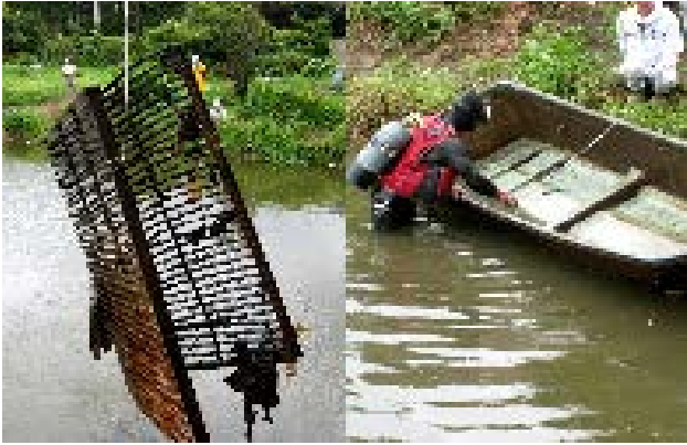
図-1 損傷した排水機場のスクリーン及び引き上げられた沈没船
