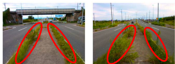
写真-1 施工前の状況
