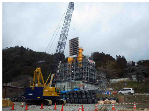
写真-3 大型型枠設置状況
