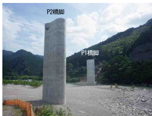
写真-6 橋脚工完成状況
