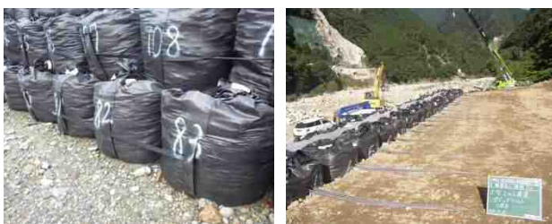
写真-2 築島工補強実施状況
