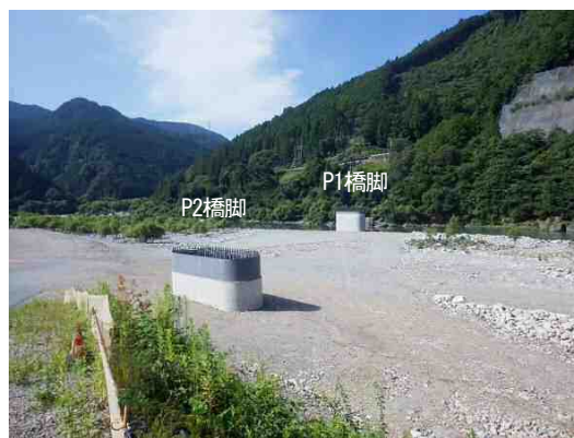
写真-5 1期施工完了状況
