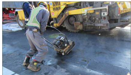
図-4-3 プレートによるサイン曲線形成
