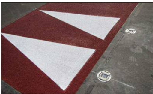
図-4-1 自発光道路鏡の設置
