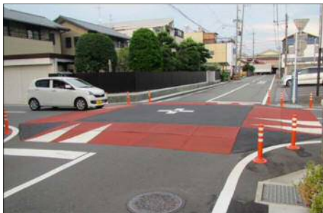
図-3-1 実証実験の様子
