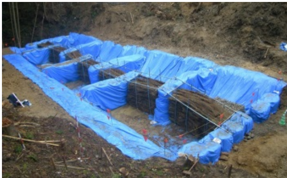
写真-1 沈砂池の設置
