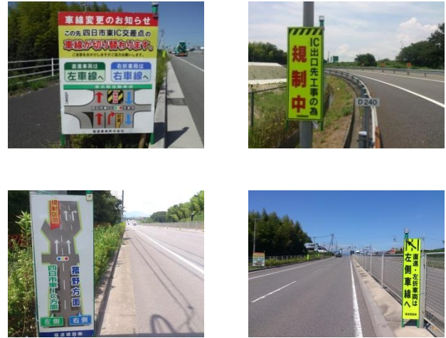
図-10 案内看板等の設置状況
