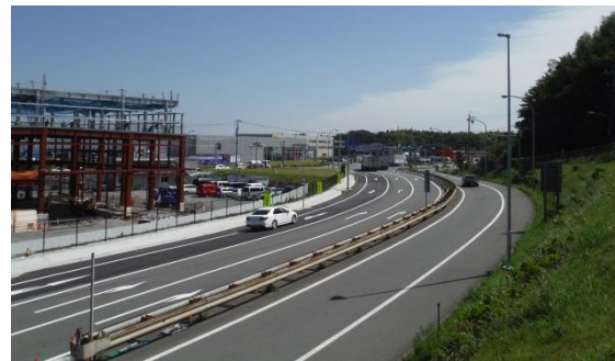
図-13 工事完了後
