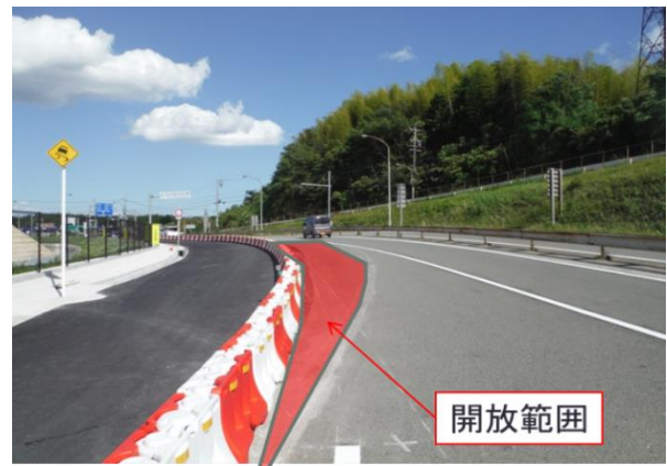
図-8 仮舗装実施状況
