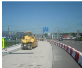
図-12 粒度調整後の締め固め状況
