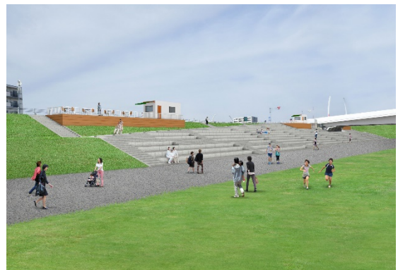
図-13 自然景観に配慮した設計の一例 (緩傾斜堤防・階段護岸イメージ)
