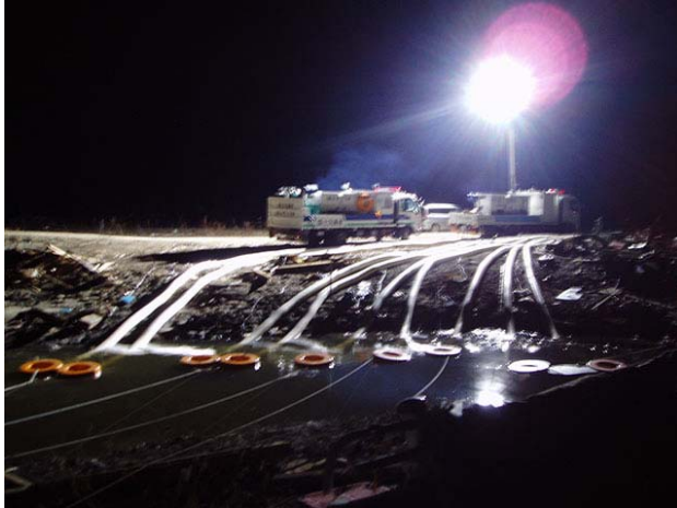
写真-2 夜間排水状況
