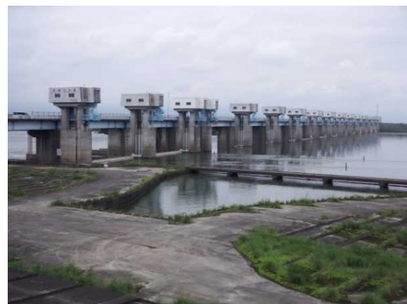
写真-2 左岸から見た木曾川大堰
