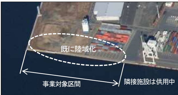
図-3 工事前の事業対象区間の状況
