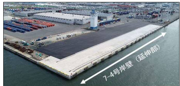
写真-1 完成した耐震強化岸壁
