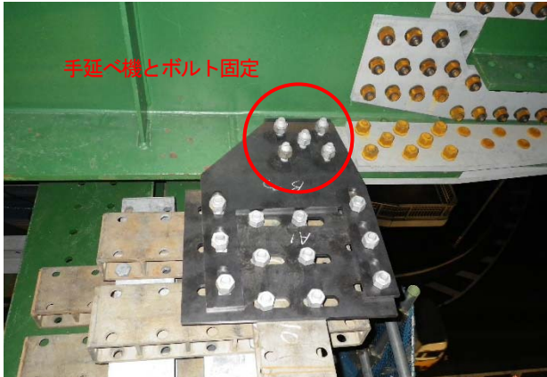
写真-3 手延べ機ボルト固定状況
