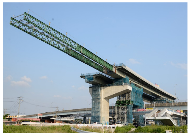
写真-6 送出し架設完了（2回目）
