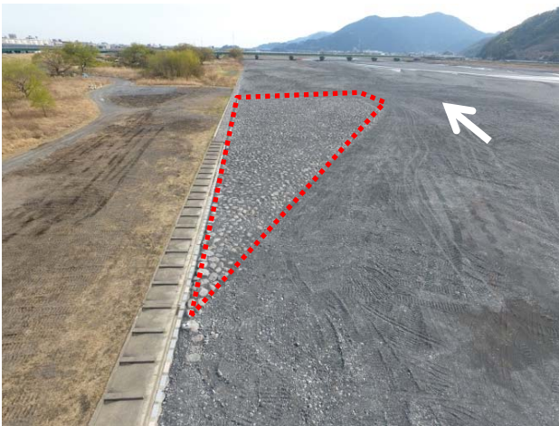
写真-4 施工完了
