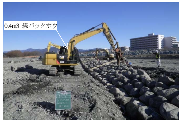
写真-2 法面部巨石据状況
