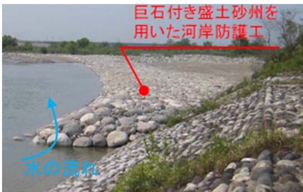
図2 巨石付き盛土砂州を用いた河岸防護工の効果
