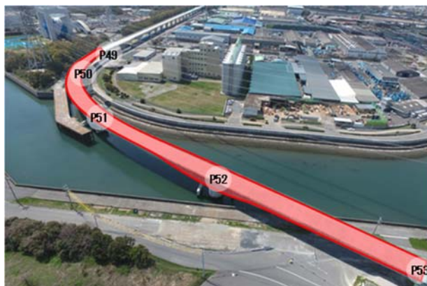
写真-2 PC4径間連続ラーメン箱桁橋区間
