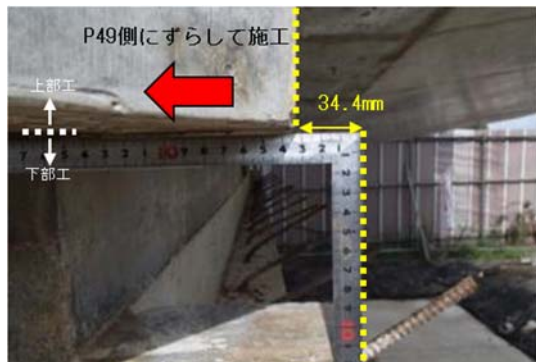
写真-3 上部工と下部工をずらした施工
