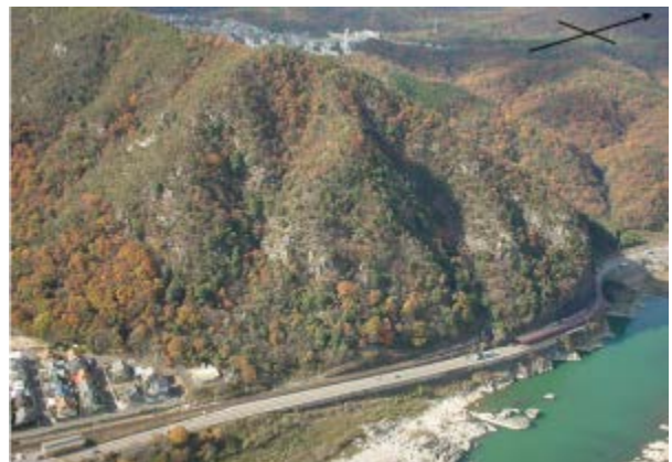
写真-1 木曾川対岸から望む対策地
