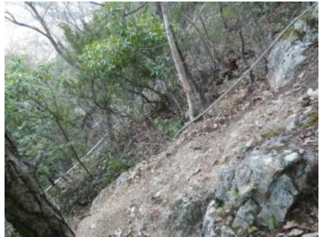
写真-7 岩塊除去工 (実施後)
