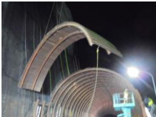
写真-9 デッキプレート撤去
