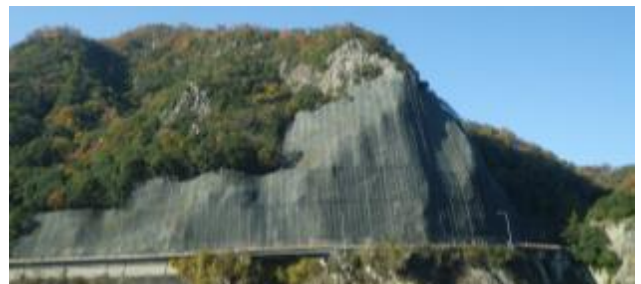
写真-10 木曽川対岸から望む対策地 (施工後)
