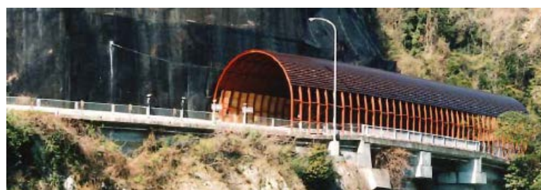
写真-3 簡易ロックシェッド (竣工時)
