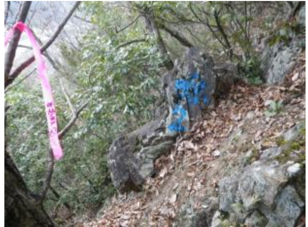
写真-6 岩塊除去工 (実施前)
