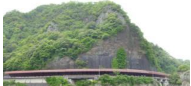
写真-10 木曽川対岸から望む対策地 (施工前)
