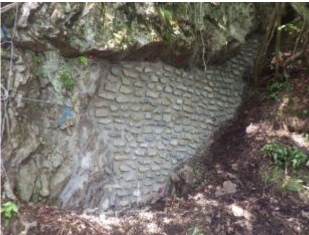
写真-5 岩接着工
