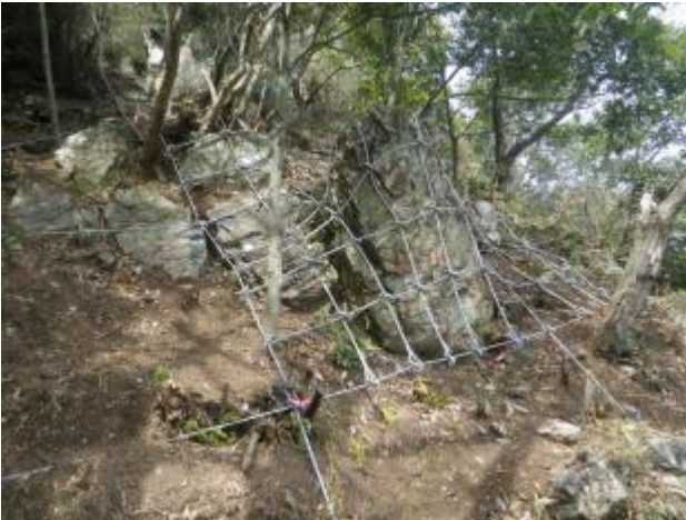
写真-4 ロープネット工
