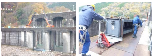
図-5 角落し設置作業
