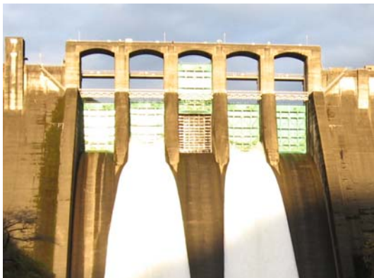
図-4 角落し設置状況（3号ゲート）
