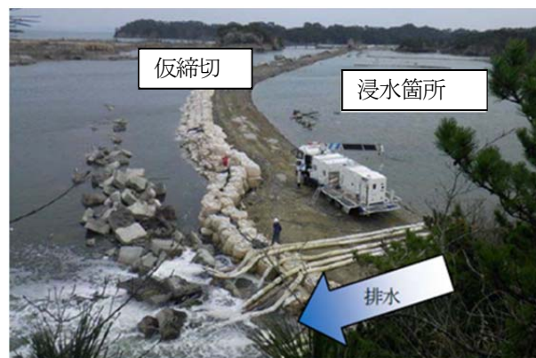
写真-1 東日本大震災での排水作業状況
