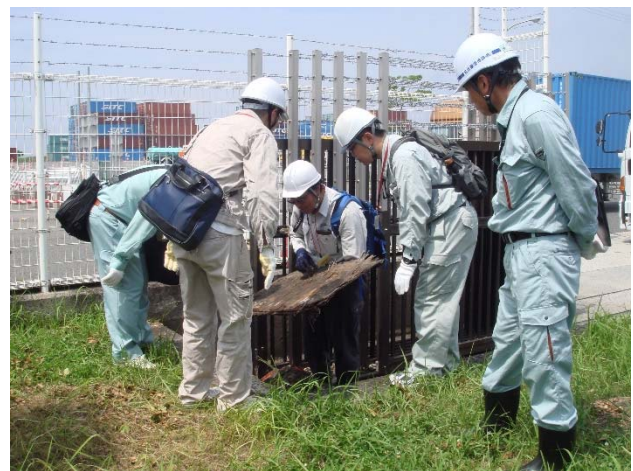
写真-3 目視による調査（名古屋港）
