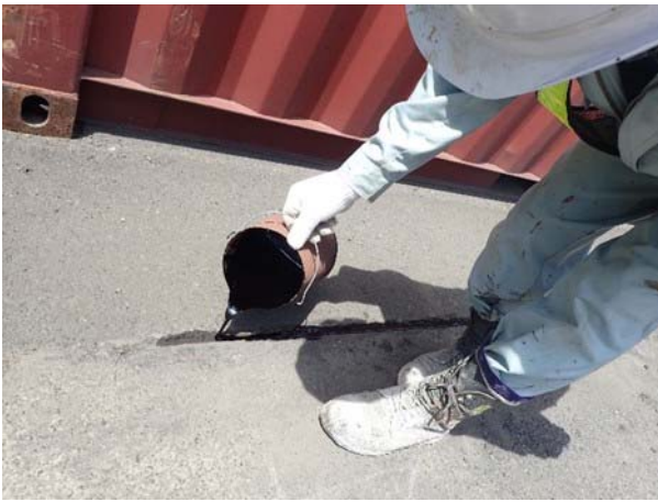
写真-4 クラック補修作業
