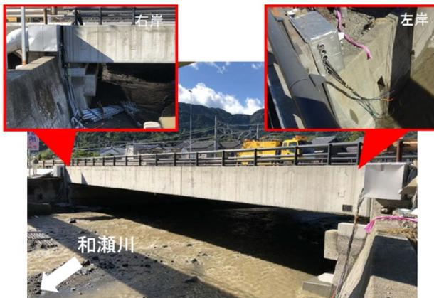
図-3 高波による光ファイバケーブル被害
