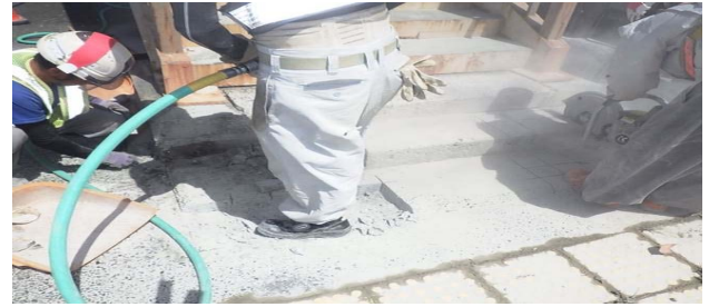
写真-5 階段部コンクリート撤去
