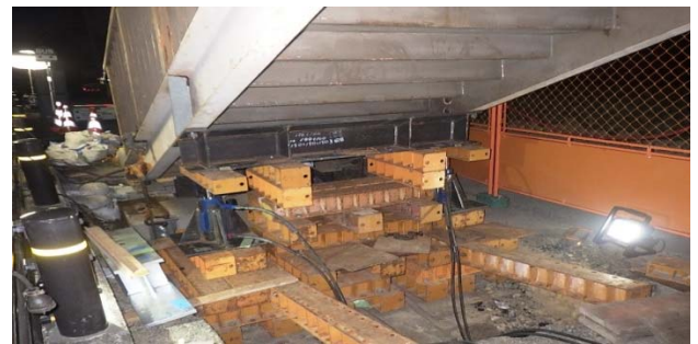
写真-6 階段部ジャッキアップ
