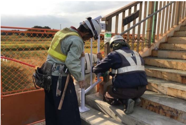
写真-8 手摺り設置
