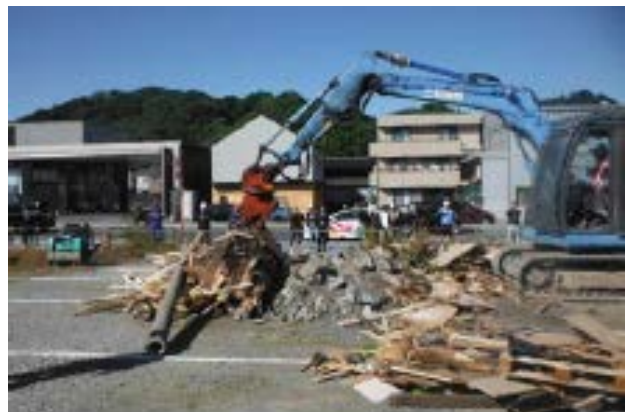
図-9 静岡県解体工事業協会によるガレキ撤去
