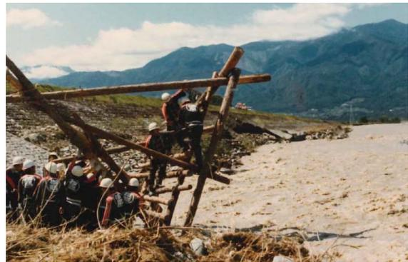
図-8 牛枠の投入(昭和57年)
