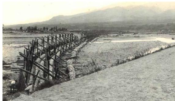
図-5 締切りのための聖牛と蛇籠(昭和13年)
