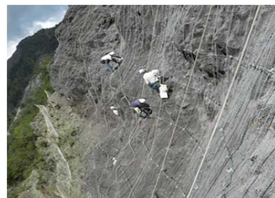
図-3 大谷山腹工の施工状況
