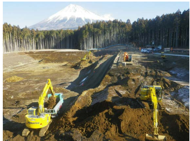
写真-2 遊砂地工事における堆砂敷掘削の様子
