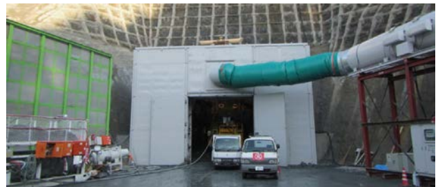
図-14 防音扉設置状況
