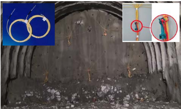
図-11 導火管付雷管と装填状況
