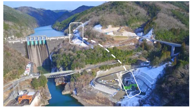
図-4 転流工遠景
