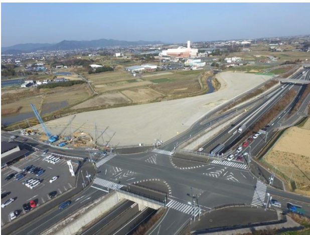
写真-2 工事完了後
