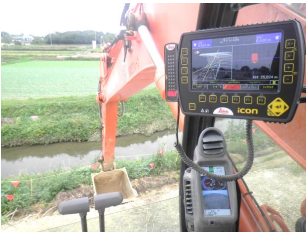
写真-5 MGバックホウによる法面整形
