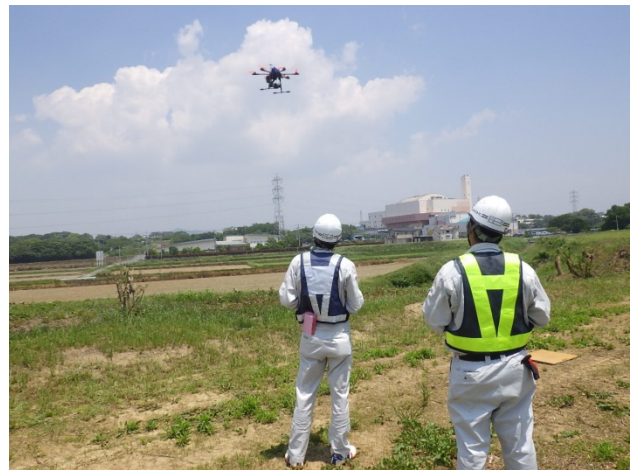
写真-3 無人航空機(UAV)による起工測量
