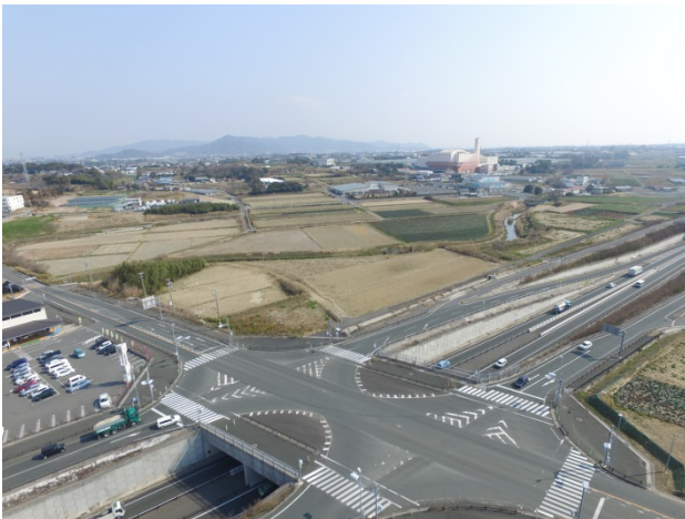
写真-1 工事着手前
