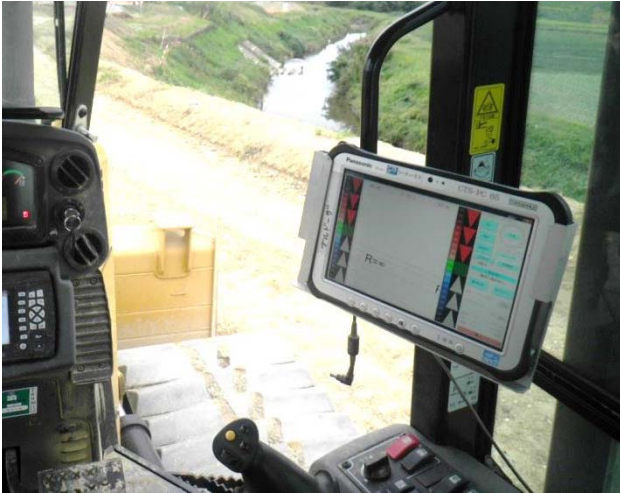
写真-4 MGブルドーザーによる敷均し
